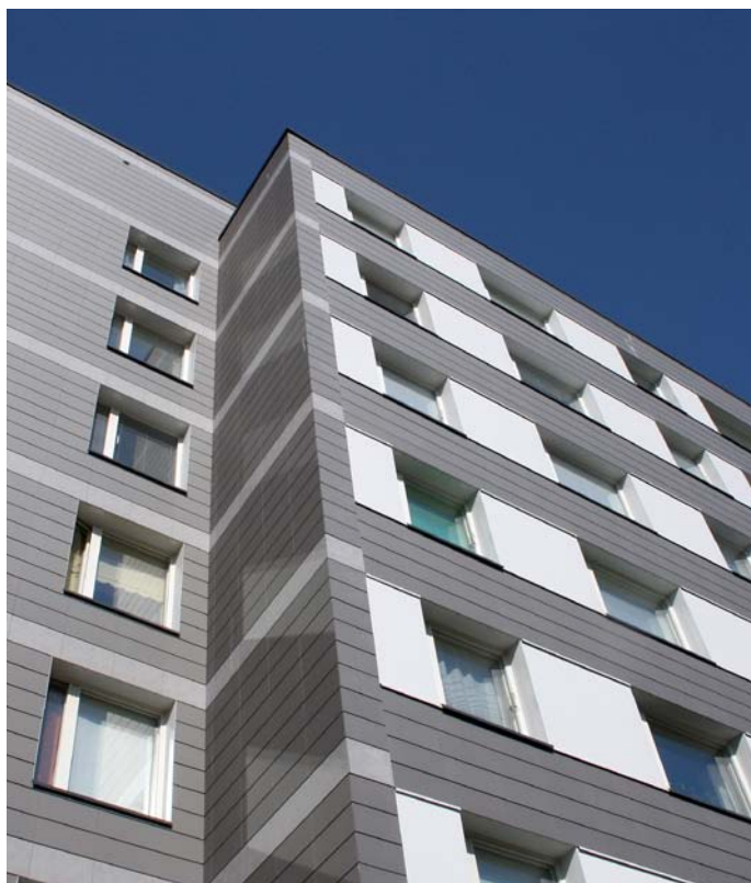
As Oy Metammelat, julkisivusaneeraus, Tampere
