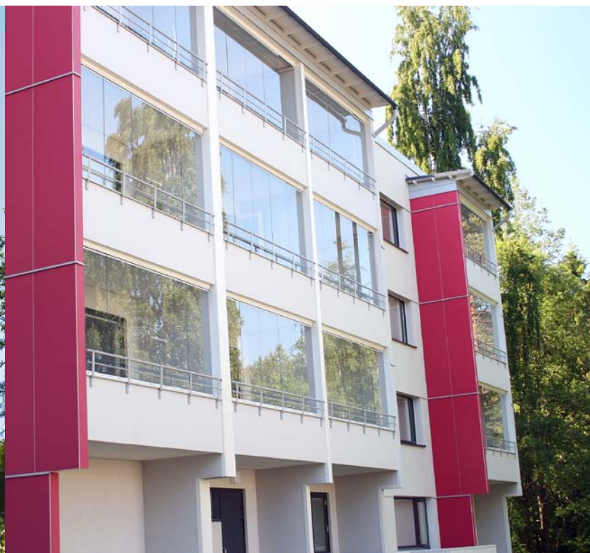
As Oy Juvankataja, Tampere, parveke- ja julkisivusaneeraus sekä ikkunoiden uusiminen
