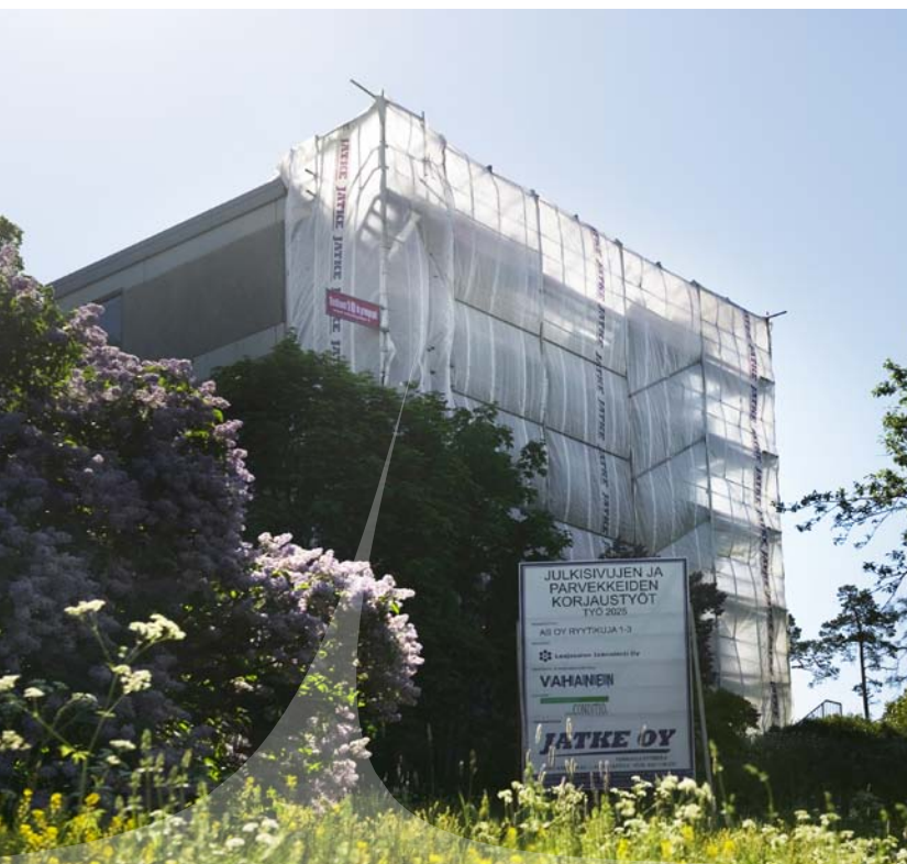
As Oy Ryytikuja, Helsinki, julkisivujen ja parvekkeiden korjaus-, kunnostus- ja uusimistyöt.
