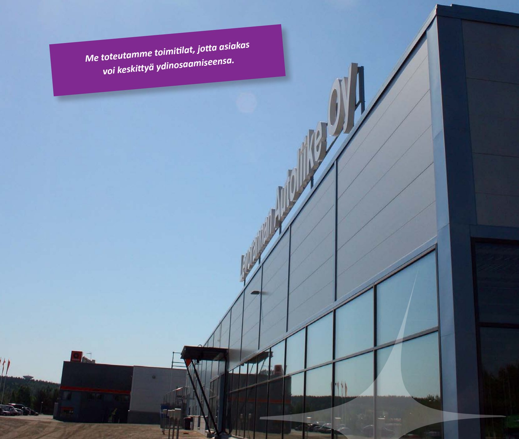
Levorannan Autoliike Oy, Tampere, liiketilan rakentaminen, uudisrakennus 2000 m 2
